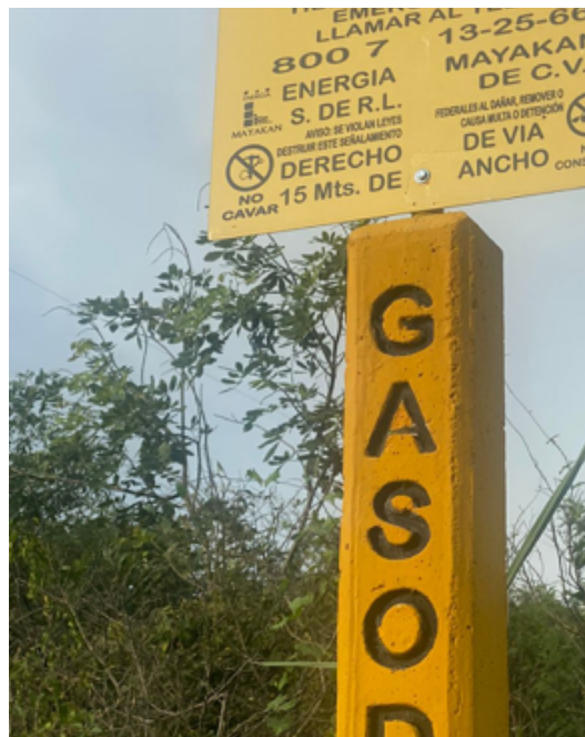
Imagen 7. a) Indicación de postes donde atraviesan ambos gasoductos a 15m de distancia b) y c) Señalización de placa de gasoducto en localidad de Pomuch, Campeche.
