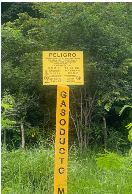
Imagen 7. a) Indicación de postes donde atraviesan ambos gasoductos a 15m de distancia b) y c) Señalización de placa de gasoducto en localidad de Pomuch, Campeche.
